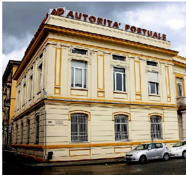
La sede dell'Autorità portuale in via del Molo a Fossamastra
