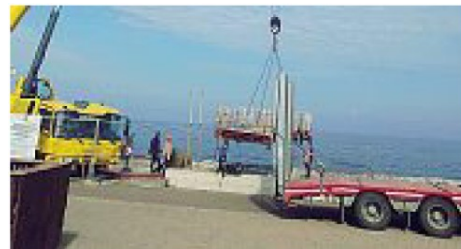
La piattaforma I lavori sulle spiagge comunali
