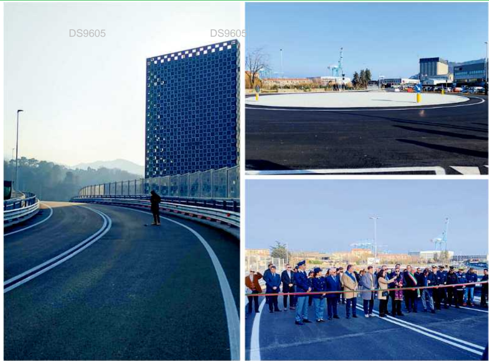
Il nuovo viadotto dedicato ai traffici del porto. A destra in alto la rotondina di via Alla Costa e sotto il taglio del nastro con le autorità
