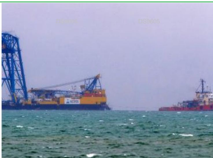
Il pontone di Micoperi in azione davanti alla piattaforma offshore chiamata 'Il ragno' che ospiterà la nave rigassificatrice Bw Singapore. Siamo a otto chilometri dalla costa (Foto Fabrizio Zani)
